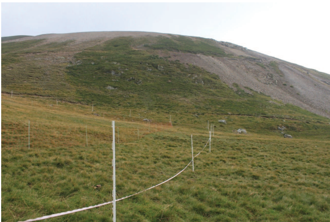
Fig. 4.13 Montaggio delle recinzioni.
